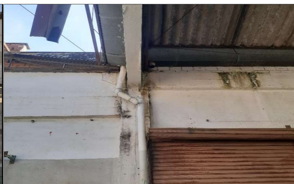
81- Cano de descida na saída da calha
