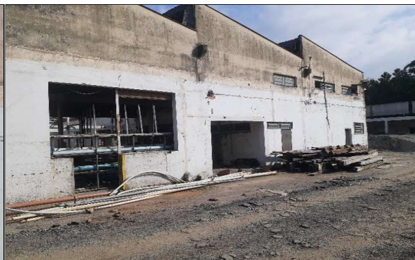
21- Fazer reparo reboco e fechar aberturas com alvenaria
