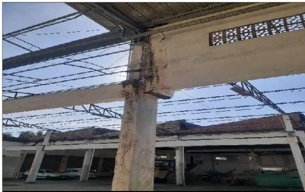
48- Reparo reboco e colocar cano de descida saída da calha
