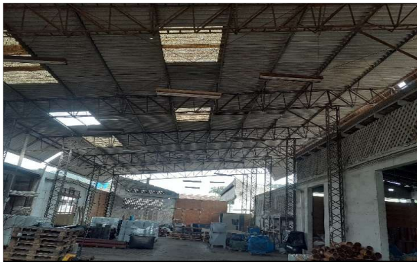
103- Lixamento e pintura a estrutura metálica da cobertura
