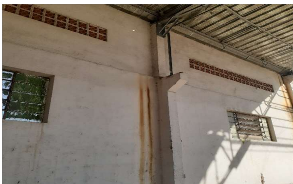
30- Calha enferrujada com furos e reparo reboco pilar
