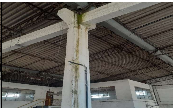
93- Colocar cano de descida na saída da calha
