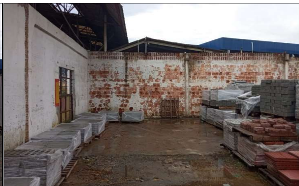
100 - Retirar tijolos furados de cima do muro e rebocar o restante
