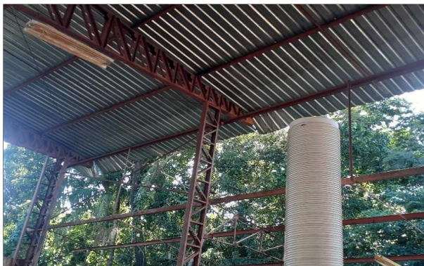
113- Trocar telhas danificadas
