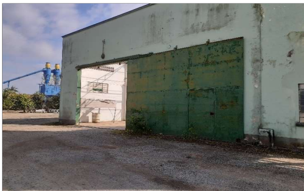
2- Retirar porta e fazer fechamento para janela de 3x0,6x2 e retirar luminária
