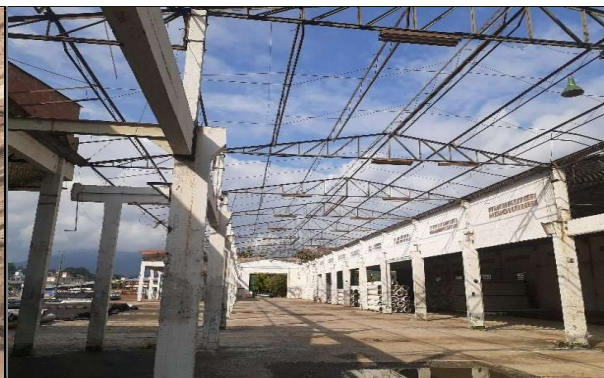
53- fazer lixamento e pintura da estrutura metalica da cobertura
