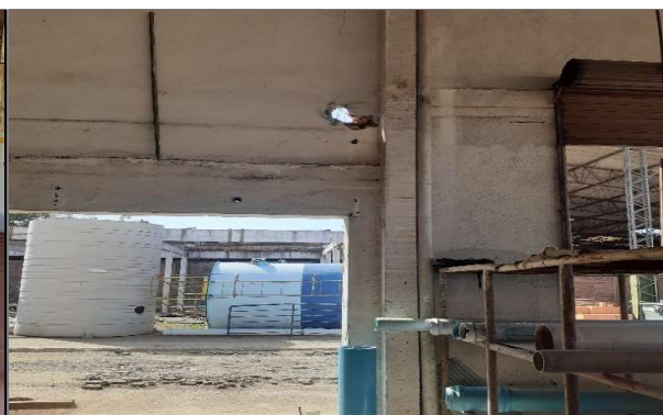
95- Fechar abertura na alvenaria
