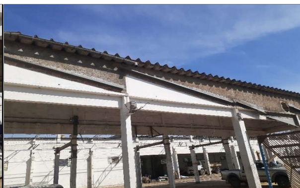
71- Executar reboco e instalar calha
