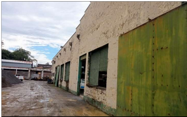
0- Fachadas com alvenaria pronta, raspar tinta, limpeza lava jato, massa niveladora, selador e pintura
