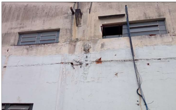
20- Reparo reboco e retirar canos e fios aparentes
