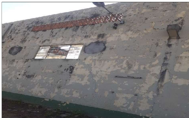
12- Pequeno reparo no reboco e retirar luminária
