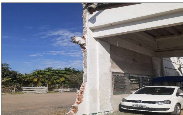
70- Reparo reboco, demolição parte de parede e requadro
