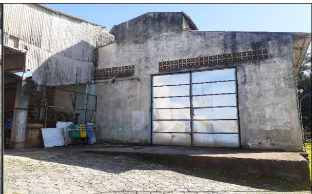
116- Reforma do portão, reparo de reboco, buraco alvenaria e calha rufo
