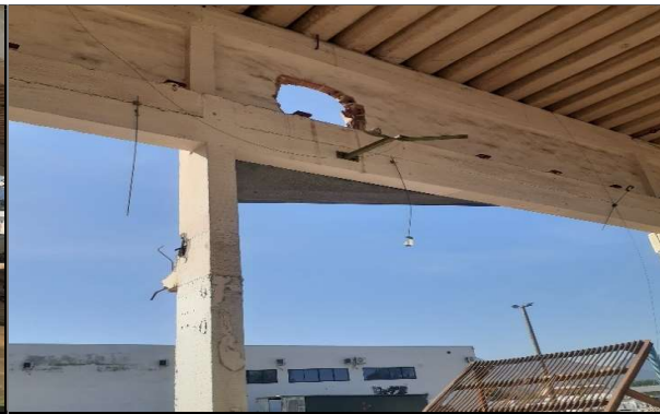
65- Fechar abertura com alvenaria
