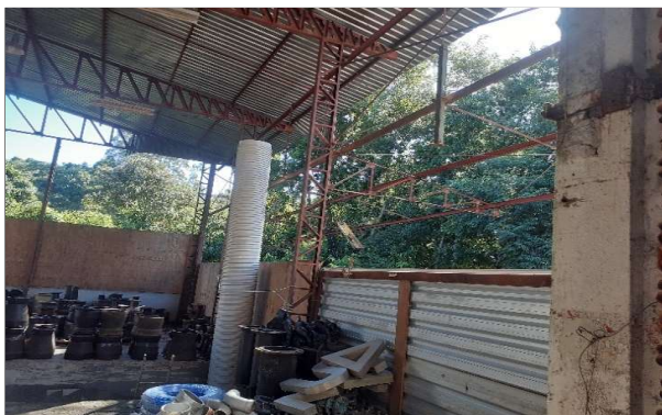
109- Retirar estrutura do telhado externa descoberta e fechamento de parede com aluzinco
