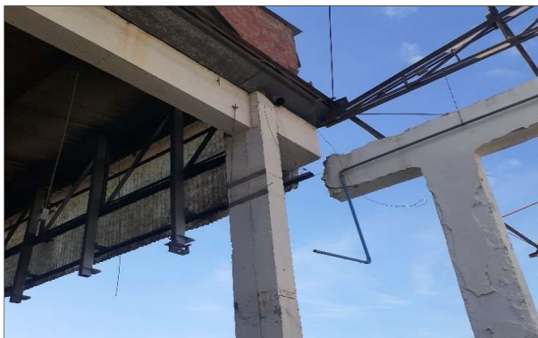
88- Colocar cano de descida na saída da calha
