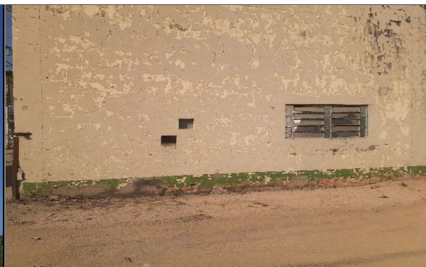
17- Refazer reboco 0.50x8m, fechamento alvenaria da janela fechar 2 buracos 0,20x0,20
