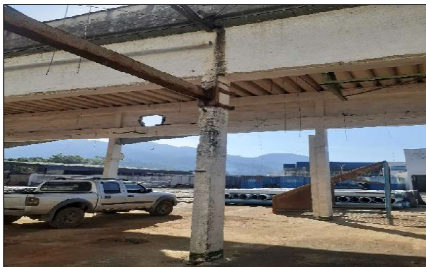
60- Reparo ferragem exposta e cano de descida da calha
