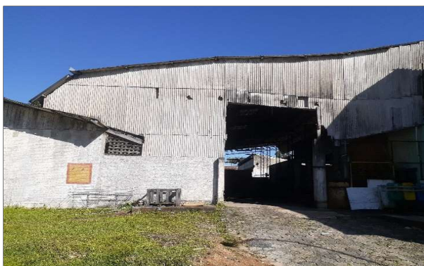
101- Retirar eternite, fazer alvenaria parede e colocar portão
