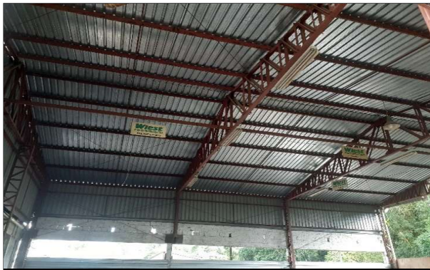
111- Lixamento e pintura da estrutura metalica da cobertura
