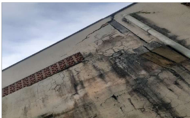
10- Reparo na alvenaria e reboco
