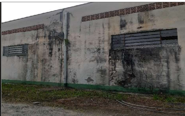
9- Retirar e refazer reboco solto 3x4,20
