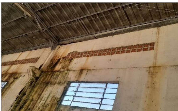
38- Alvenaria solta
