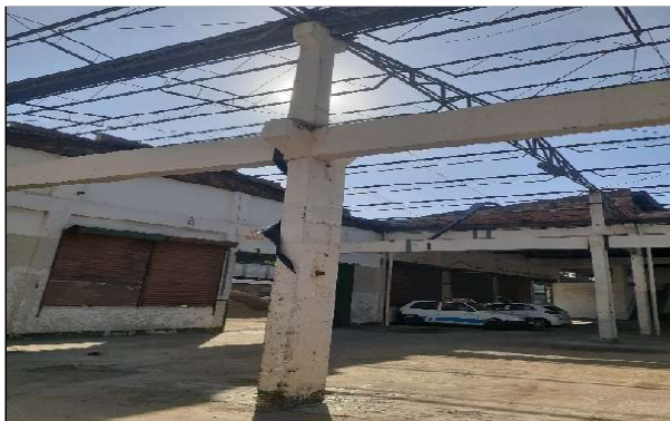
50- Reparo reboco e colocar cano de descida saída da calha
