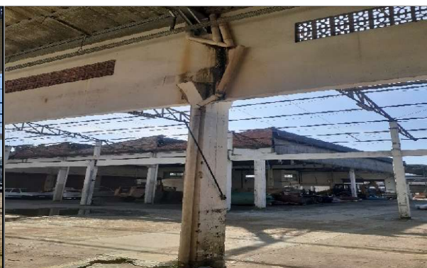
47- Reparo reboco e encanamento calha
