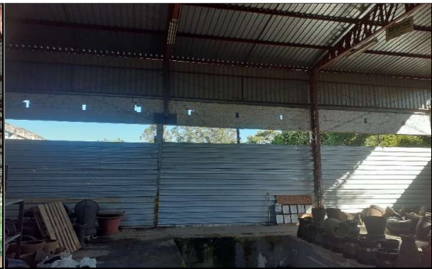
112- Retirar alvenaria e fazer fechamento em aluzinco
