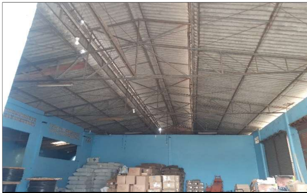
125- Lixamento e pintura da estrutura metalica da cobertura
